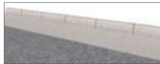
▲コンクリート縁石
